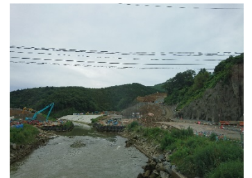
・現在も復興の工事中でした
