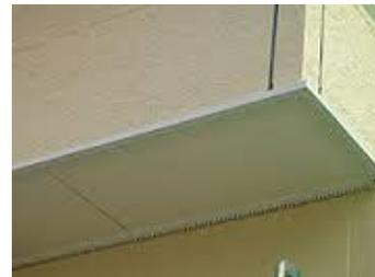
両方とも外壁はサイディングです。外壁の内側に隙間を作る通気工法で施工されていますが、天井と外側の外壁の末端に差があります。正しい施工は右側で白色のオーバーハング水切と呼ばれる部材が取り付けられています。外壁の内側の通気性を確保する事、結露や万一の雨漏りの時の水はけ口として必要な部材です。
