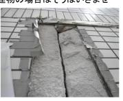
鉄筋コンクリートの建物に比べて、木造やALC造の建物は、 建物自体の動きが大きく、タイルを張る事に適しているとは 言えませんので、美観維持の為ではなく、危険回避の為に、 外壁タイル面のメンテナンスを行う必要があると考えます。
