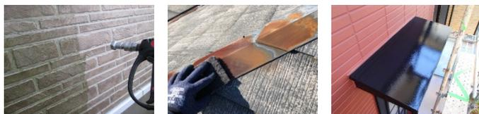
例を上げると、上の三枚の写真は、左から「外壁の洗浄」「鉄部のペーパー掛け」「死角となる高い位置の庇の塗装」の写真です。
